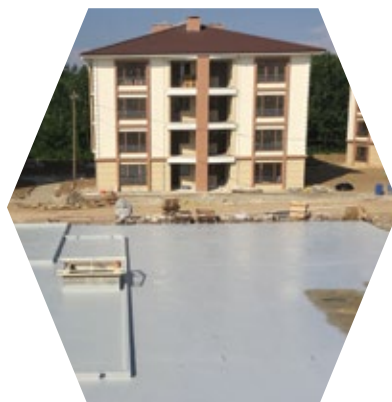
Foundation and concrete curtain walls Hormigones de cimentación y cortina
