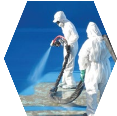
Pools and ponds Estanques de agua, piscinas, tuberías de agua
